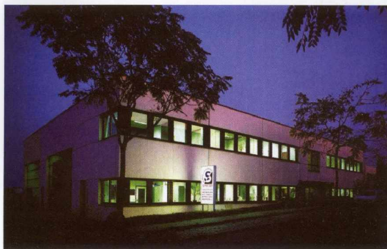
1: Schneider Werkzeugmaschinen im Industriegebiet Böllinger Höfe an der Autobahn Heilbronn – Mannheim
